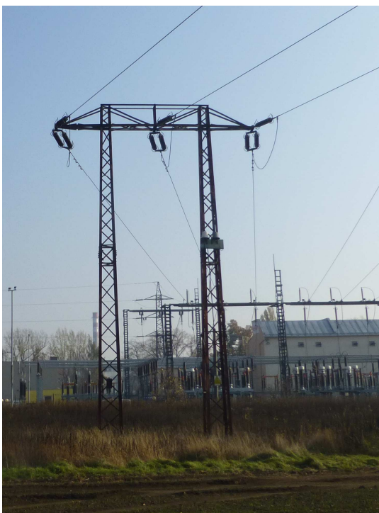
Obr. č.1_Pohled na rohový výztužný stožár „sedlák“
