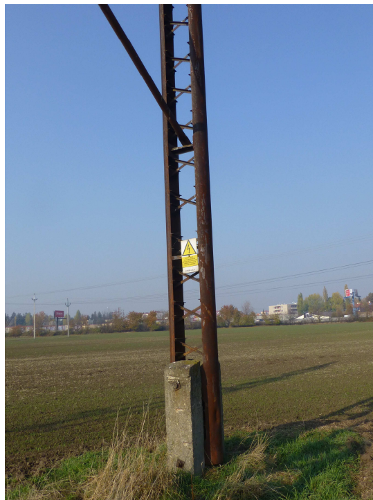
Obr. č.4 Pohled základ nosného stožáru
