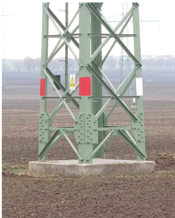
Obr.č.6 základ pro výstužní stožár SOUDEK
