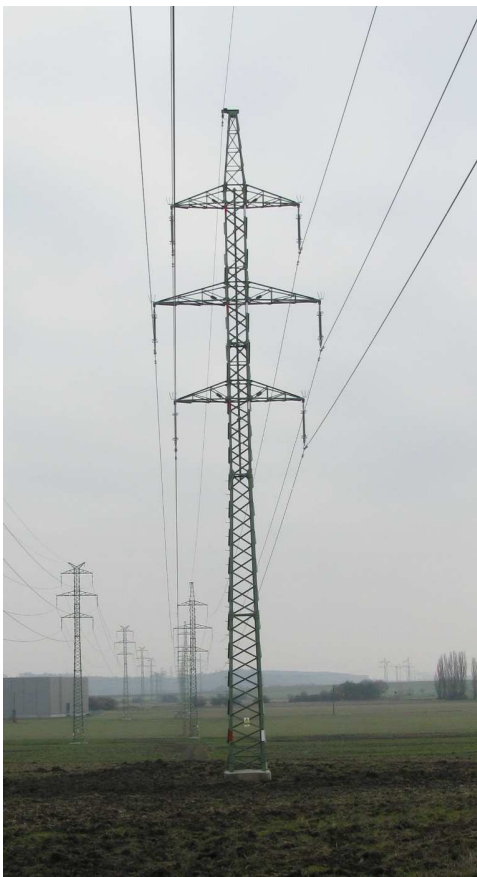
Obr. č.7 Pohled na typický nosní stožár typu SOUDEK Obr.č.6 základ pro nosní stožár SOUDEK
