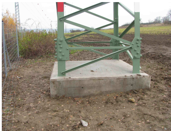
Obr. č.7 Pohled na typický nosní stožár typu SOUDEK Obr.č.6 základ pro nosní stožár SOUDEK
