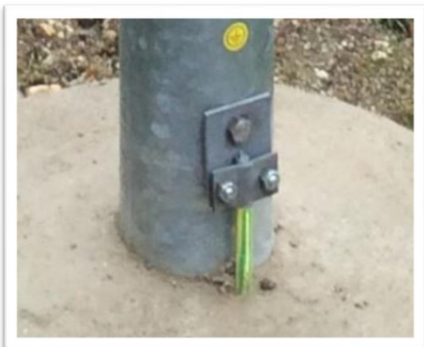
Obrázek 5 - Zemnění a stožárová svorkovnice
