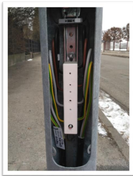
Obrázek 5 - Zemnění a stožárová svorkovnice
