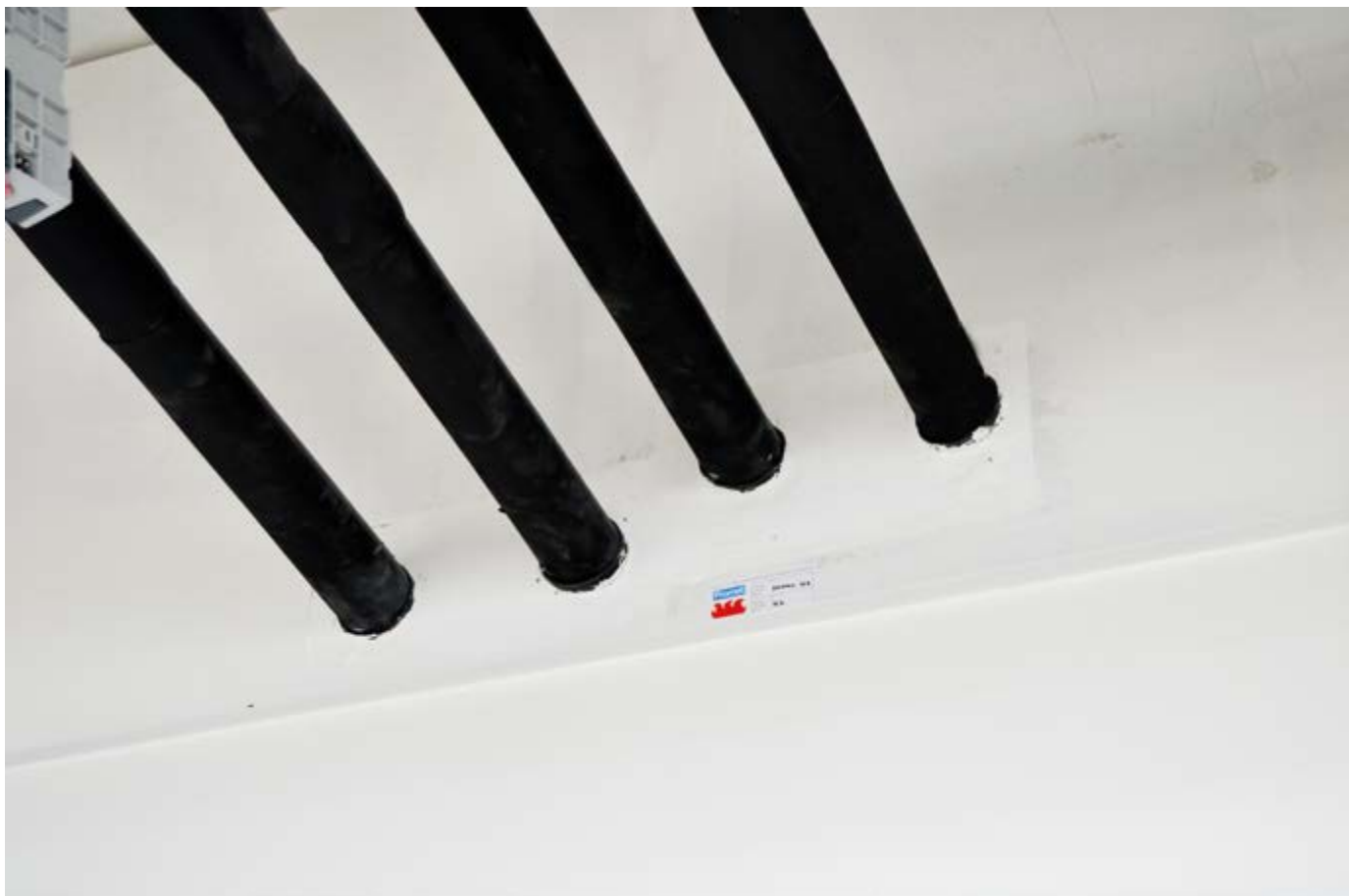
Prostupy potrubí s požárně ochranným pásem PROMASTOP®-W
