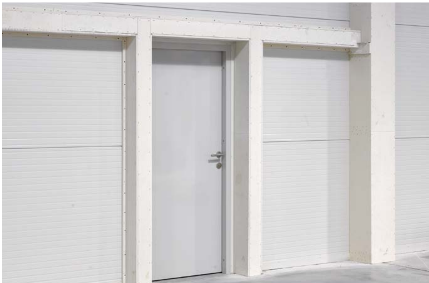
Obklad ocelové konstrukce deskami PROMATECT®-XS 320
