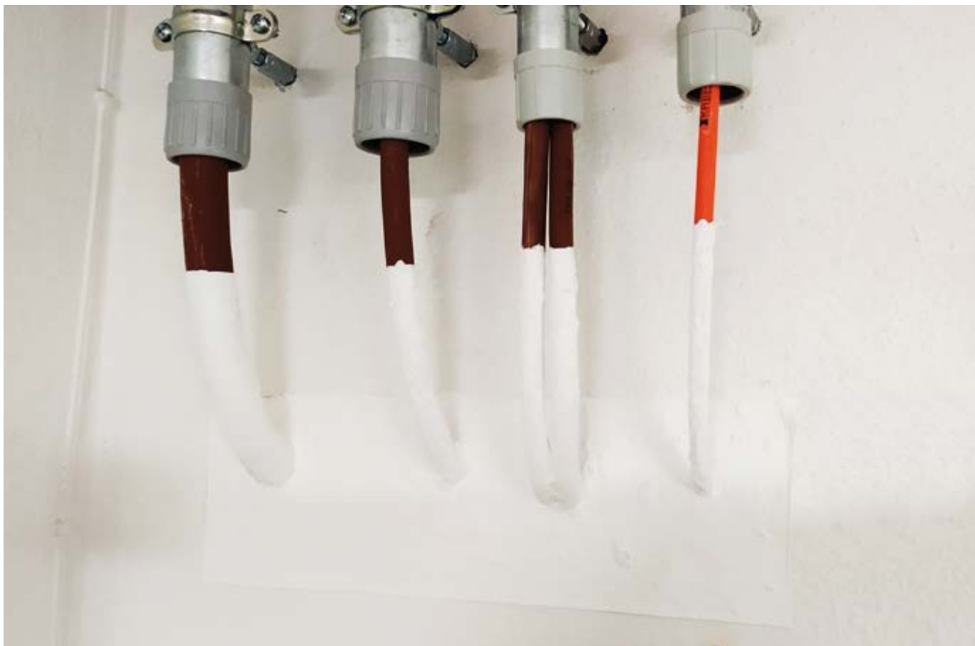
Kabelová měkká desková přepážka se stěrkou PROMASTOP®-I
